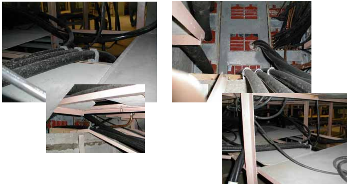
北海道電力株式会社殿 金山発電所内配線工事
